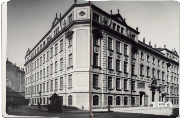
Edifici del Grup Escolar Milà i Fontanals, 1922.
